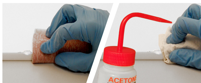
3. Carteggiare con tampone carta Grana 500 (D) solo vicino alla parte danneggiata, rimuovere la polvere e sgrassare la superficie utilizzando acetone o alcool.
