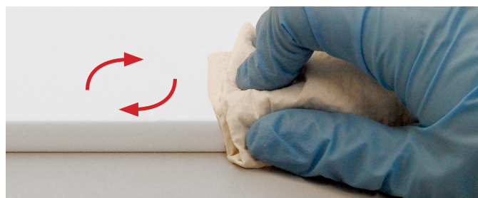
9. Lucidare con il polish (I) in modo energico per riportare la superficie alla brillantezza iniziale.
